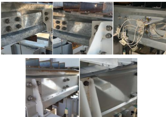
Figura 4.3.1. Modo de falha, respectivamente, da ZPRO200-1,25-1; ZPRO200-1,25-2; ZPRO300-1,25-1; ZPRO300-1,55-1; e ZPRO500-1,70-1.
